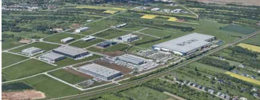
A német BSH új gyártóüzeme a lengyelországi Rzeszówban. Ez az egyik kevés európai kisgépgyártó üzem, ráadásul egy teljesen újonnan indított beruházás.
